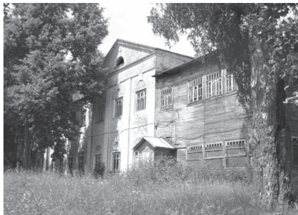
Рис. 16. Производственный корпус XVIII в.
