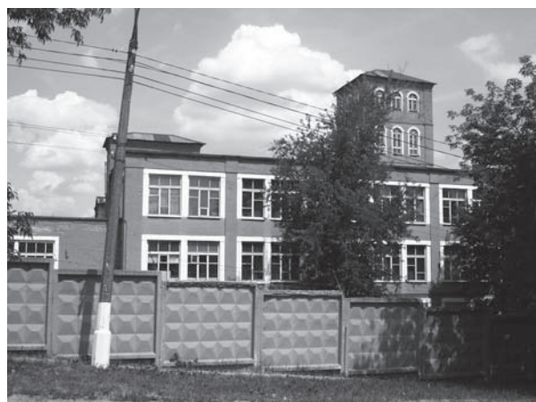
Рис. 17. Фряново. Производственный корпус XIX в.
